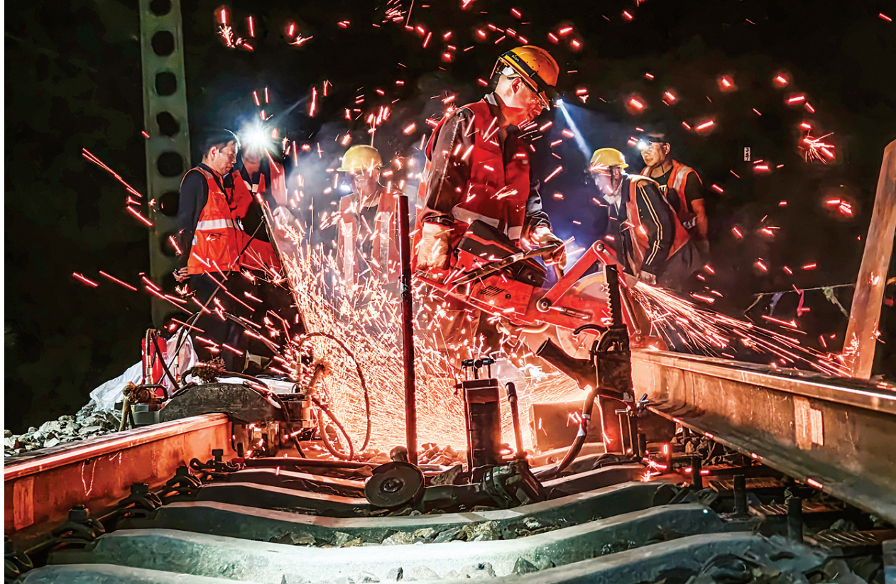
7月20日晚，为期25天的太中银铁路集中修施工。图为工人正在更换钢轨。 牛利敏 王林庆 摄影报道
