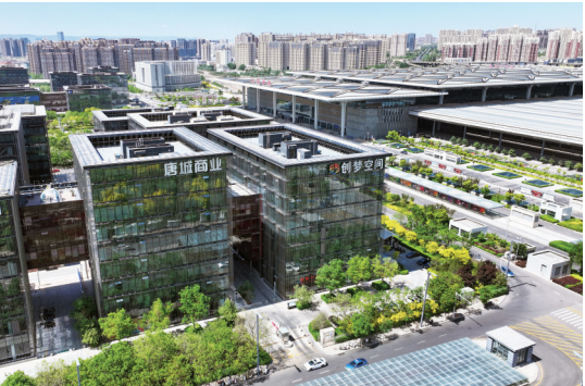
南站片区写字楼。
