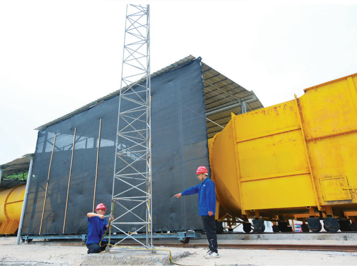
入汛以来,山西焦煤西山煤电官地矿扎实推进雨季“三防”工作。工作人员对辖区内山间防洪渠、设备设施、边坡地质隐患全方位巡查整治,提前疏通排水通道、加固边坡、检修防汛设备,抓实隐患排查与物资保障,保障矿井平稳安全度汛。图为工人检修风机房避雷针设施。
