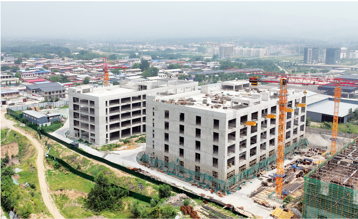
8月2日,坐落于阳曲现代农业产业示范园区的山西同创大健康创新综合体项目,主体结构施工进入收尾阶段。项目总建筑面积达10.88万平方米,建成投用后,将补齐本地大健康产业配套,贯通大健康全产业链条,有力助推当地生物医药产业集群高质量发展。 张昊宇 摄
