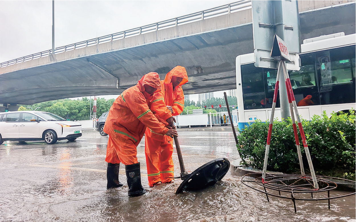
8月4日，我市迎来降水，市市政建管中心快速响应，全力投入城市排水和疏导工作。图为道排保障二所工作人员在西中环兴华街口清理进水井口杂物。
