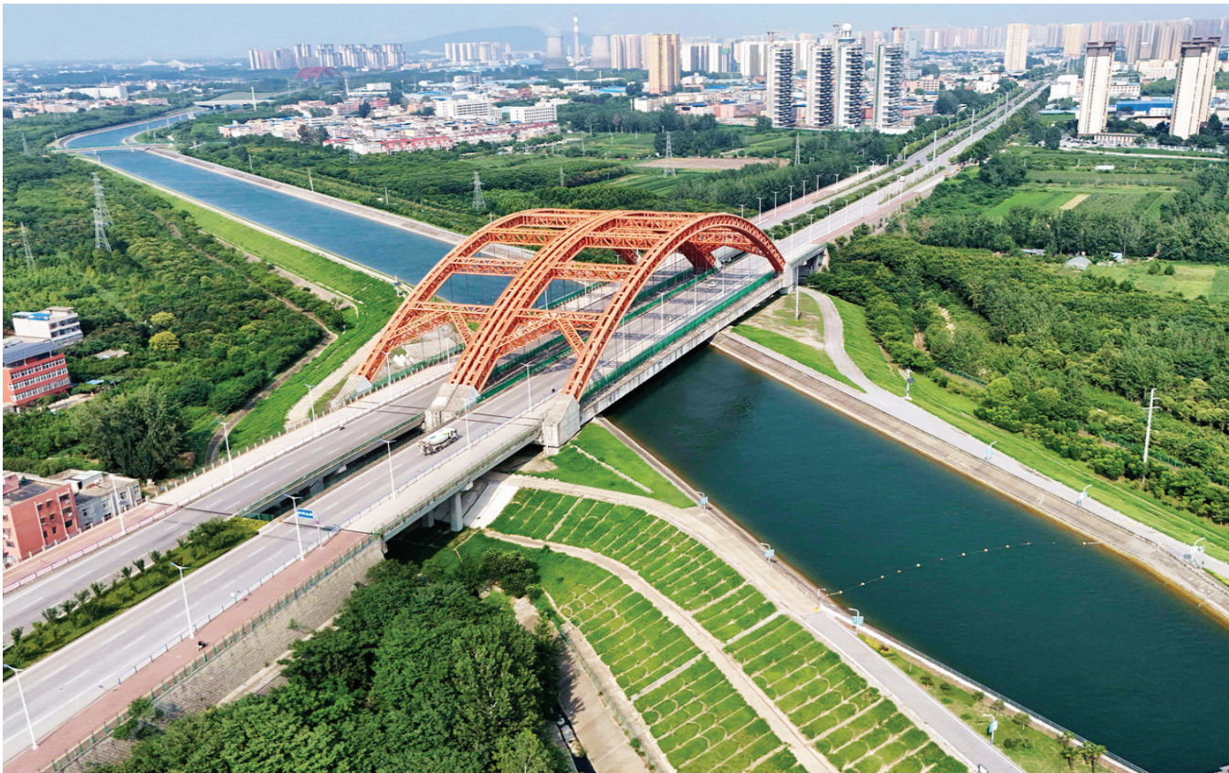
这是8月7日在河南省南阳市拍摄的南水北调中线工程干渠景色(无人机照片)。据中国南水北调集团发布的数据,截至8月7日,南水北调中线工程累计向北方调水突破800亿立方米,惠及河南、河北、天津、北京近1.18亿人,为沿线27座大中城市243个县(市、区)经济社会发展提供有力的水资源支撑。 新华社发(高 嵩 摄)
