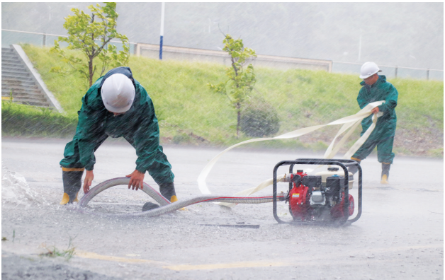
8月9日，浙江省台州市三门县海游街道工作人员开展积水抽排和排水管道疏通作业。
