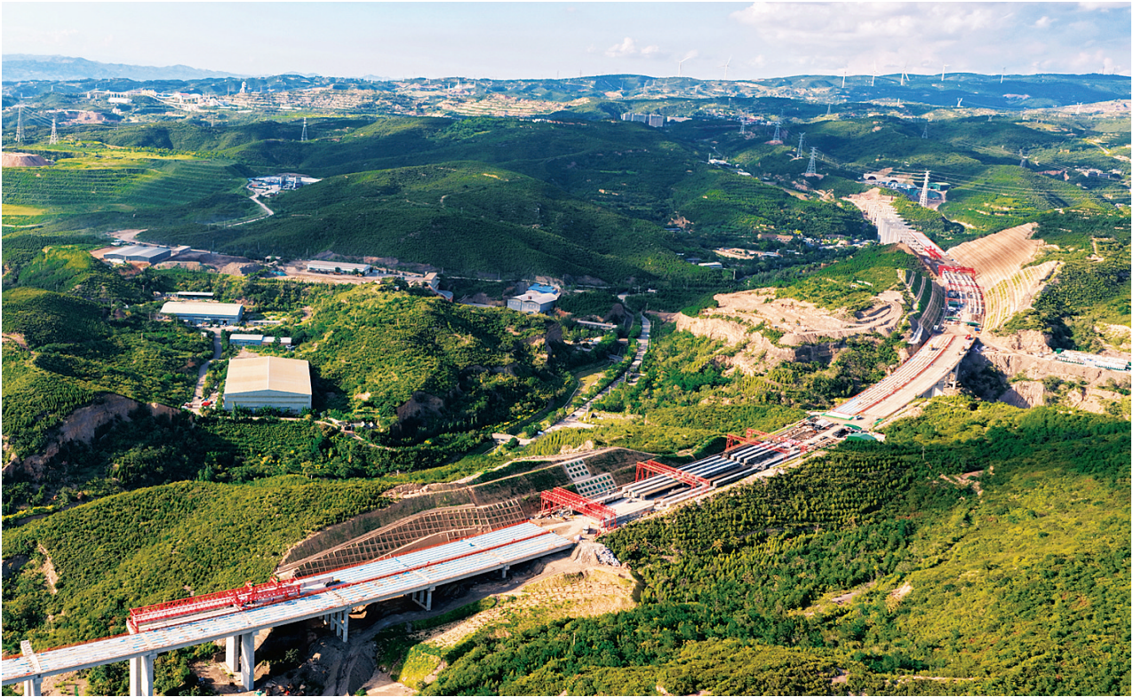
8月18日，青银二广高速公路太原联络线项目太原段建设现场，施工有序推进。目前，太原段总体工程进度已达82%，南沙河大桥、麻地沟大桥、柳沟1号大桥各分项工程按节点加紧施工，桩基、墩柱等基础下部工程大多完工，上部梁板架设稳步推进。
