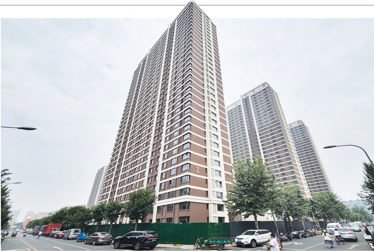
8月19日,中铁十二局承建的大太原市大众棚户区改造回迁安置EPC总承包项目进入收尾阶段。多年来,中铁十二局积极参与太原交通路网、城市配套、重点产业配套工程建设,持续完善城市功能布局,为城市更新升级、经济高质量发展持续贡献力量。
