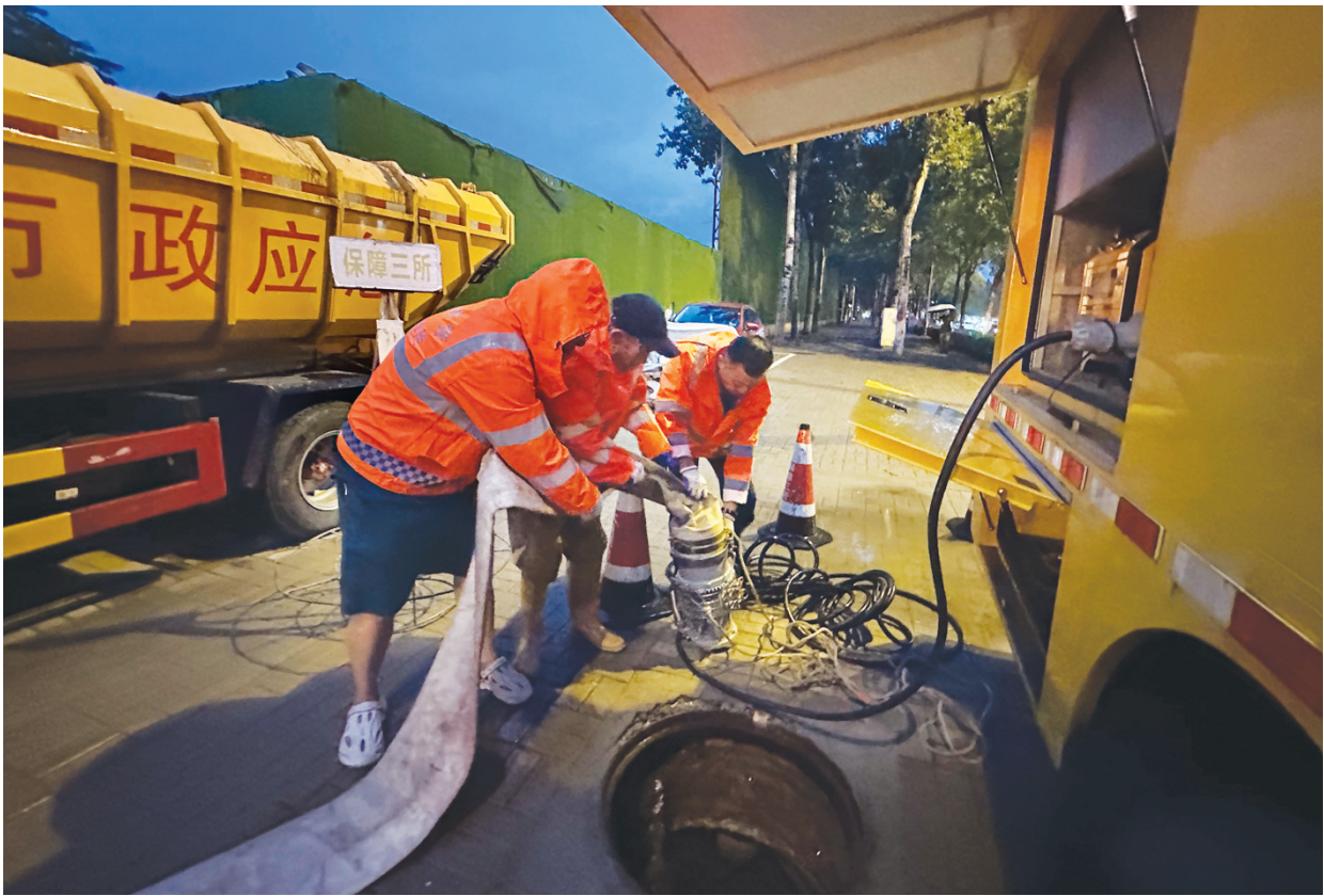
8月26日,太原市政建管中心工作人员在长风西街新晋祠路口布设抽水排涝设备,应对强降雨天气。牛利敏 摄
