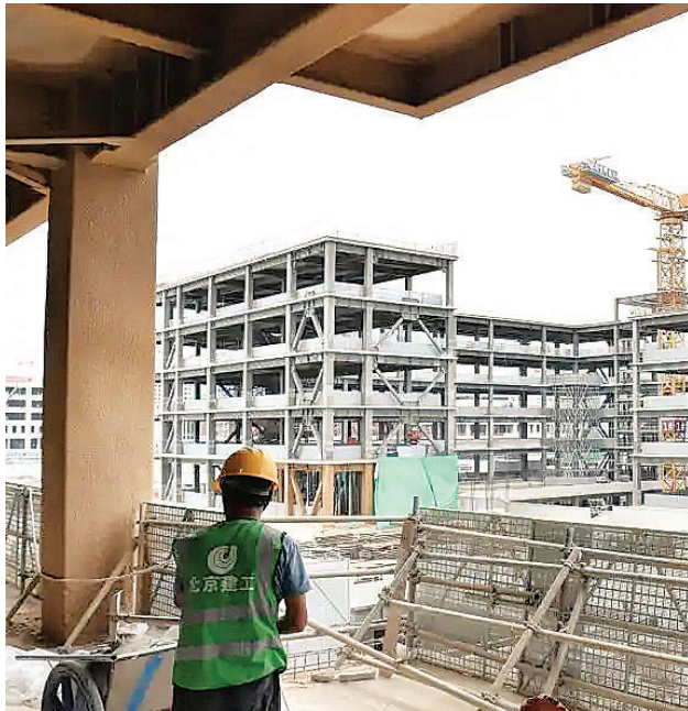
8月24日，北京科技大学雄安校区最大单体建筑图书馆主体结构封顶。
