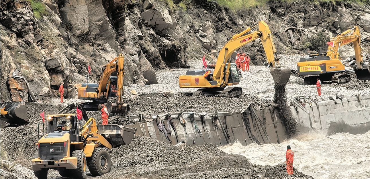
8月27日，救援车辆在为通往灾区的道路清淤。吉隆泥石流灾害发生后，西藏自治区交通运输厅及时启动交通运输行业一级应急响应，迅速组织力量对通往吉隆口岸的G216线受灾路段开展抢险保通作业。截至8月27日18时，受灾路段已抢通800米左右。
