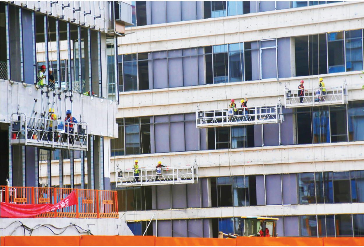
8月29日,位于中北高新区的晋创谷太原科技和产业创新融合区建设项目(晋创谷二期)正在加紧建设。该项目由中铁十二局集团承建,总建筑面积58.6万平方米。目前,6座主要建筑的主体已封顶,开始室内装饰装修、外立面安装、绿化亮化等施工。
