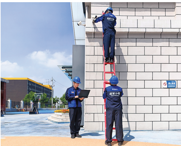
客响中心党支部成员在安装调试设备。
