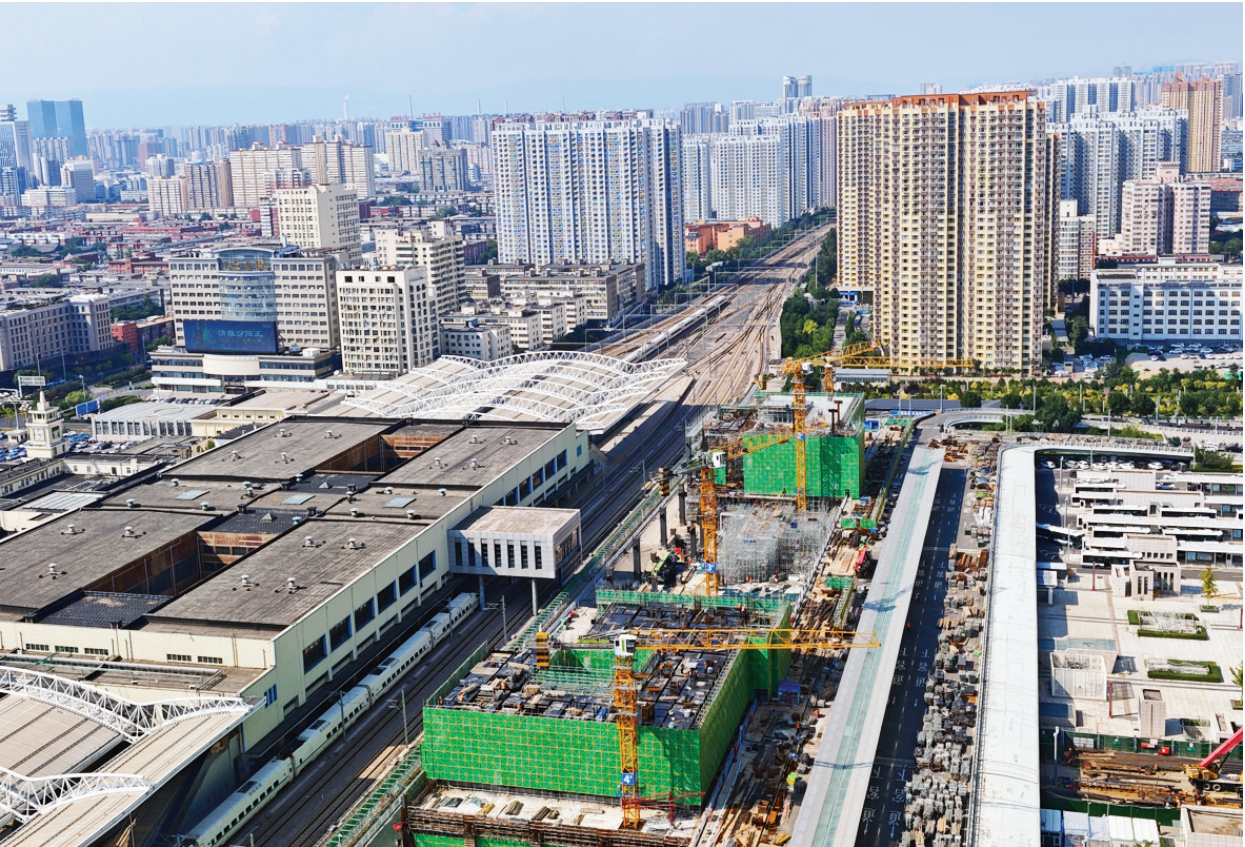
新建太原站东站内地下工程已按期完成节点目标，项目建设全面转入地上主体结构施工阶段。据悉，太原站东站内房位于迎泽区太原站东侧，高29.7米，建筑面积34765平方米，由地上四层(含夹层)、地下二层两部分组成，建成后将成为集铁路运输、轨道交通、公交出租、商业文旅于一体的现代化综合交通枢纽。图为9月2日的施工现场。 牛利敏 摄
