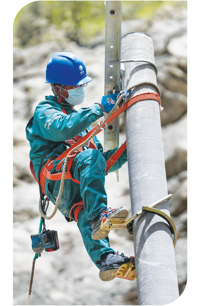
9月3日，在吉隆泥石流灾害核心区，电力工人进行安装作业。新华社记者 晋美多吉 摄
