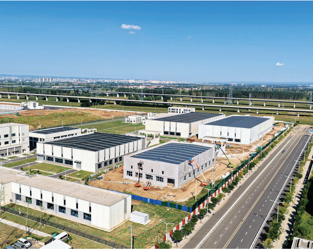
9月7日，山西转型综改示范区潇河园区供水工程二期项目四个单体建筑全面封顶。目前，施工正在进行附属设施建设。作为服务区域产业、惠及民生的重点基础设施项目，该工程主要建设净水车间、炭滤池车间等单体建筑及备用水池，项目建成后将为晶科、太重等一批重点企业稳定供水。
