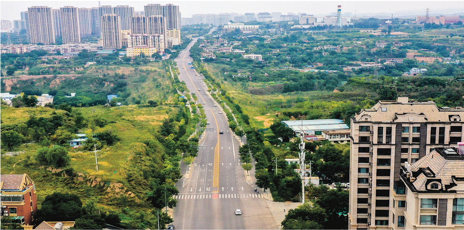
9月7日,车辆平稳行驶在迎泽区东山片区崭新宽阔的马庄路上。此前,该路段路面狭窄、配套缺失,周边居民长期面临出行绕路、路况差的难题。经过系统性改造后,通行条件得到改善,居民出行更便捷。
