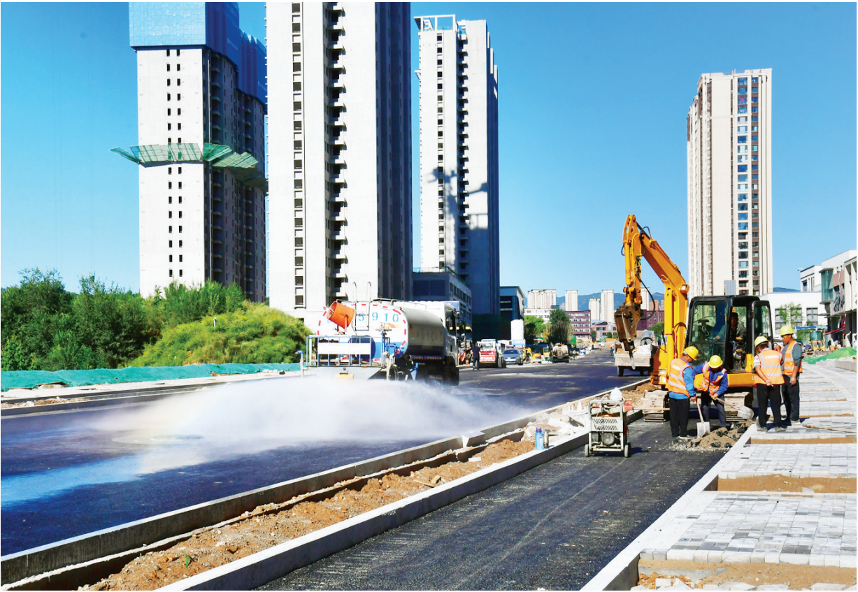
9月12日,位于万柏林区的光华街北側30米规划路道路工程已接近尾声,工程施工范围包括光华街、光华街南北侧规划路、西峪路西侧规划路等。 赵世凯 摄
