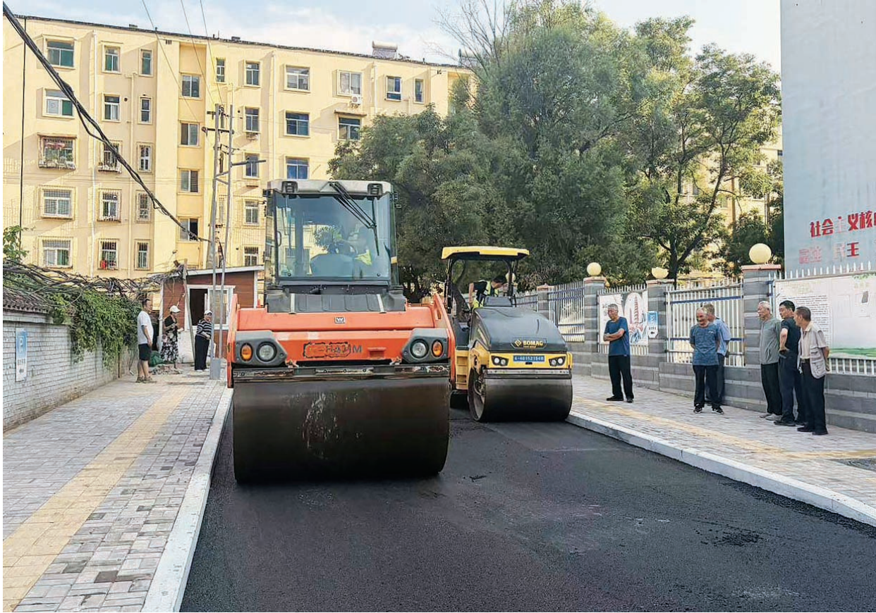
9月13日，随着工程机械完成沥青铺设，万柏林区朝南西巷雨污分流改造工程顺利完工。该工程历经2个月施工，有效解决了街巷老旧、雨污水混流难题，改善了周边通行环境。 牛利敏 杨 斌 摄影报道
