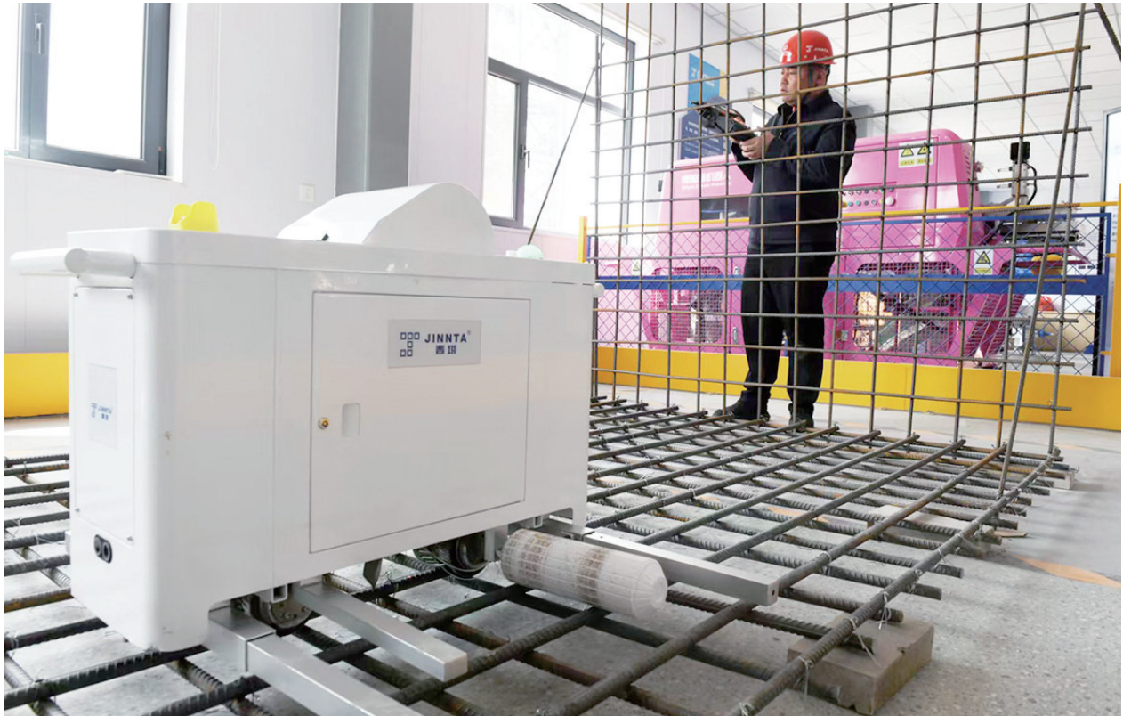
9月17日,山西省工程机械有限公司工作人员正在调试钢筋绑扎机器人。该机器人可自主精准识别钢筋节点,自动完成全流程绑扎作业。目前,山西三建集团已将机器人使用纳入产业工人专项技能培训,助力省内建筑施工智能化、标准化。 郭苑甫 王三敏 摄影报道
