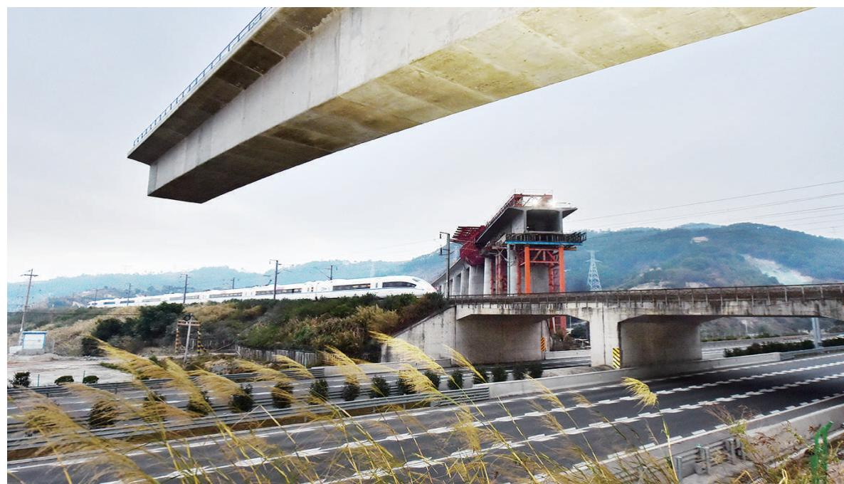
1月11日拍摄的待转体的新建福厦铁路青口特大桥2—100米T构梁。
