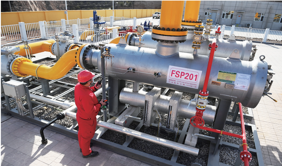
2月17日,太原东山中石油昆仑燃气有限公司孟家井门站内,工作人员正在例行检查站内压力表。据了解,该门站接上游来气经过两级过滤、计量、调压为下游供气,为省城迎泽区、杏花岭区“煤改气”居民春节期间供暖用气提供有效保障。
