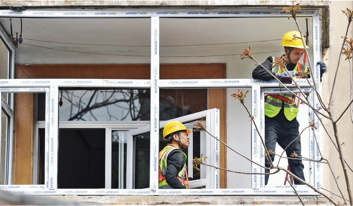
4月5日,施工人员正在为校尉营小区的居民楼安装墙体保温材料和节能窗户。今年我市将启动10个城中村、3个棚户区改造,完成老旧小区改造700个以上,同步推进既有住宅加装电梯、既有建筑节能改造,努力实现从“住有所居”向“住有宜居”转变。
