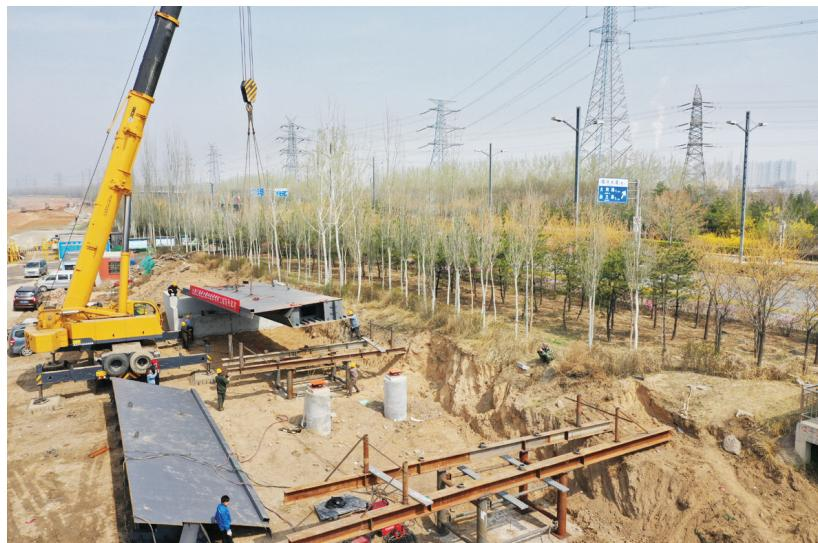
4月6日,新建的杨兴河景观桥建设工地上,工人们开始在桥墩上架设钢梁。该桥位于滨河东路西侧,阳兴大道附近,全长200米,桥宽8.5米。作为滨河自行车专用道工程的一部分,未来,市民可骑行在桥上,一边锻炼身体,一边沿途欣赏汾河景区的美景,感受大自然风光旖旎。
