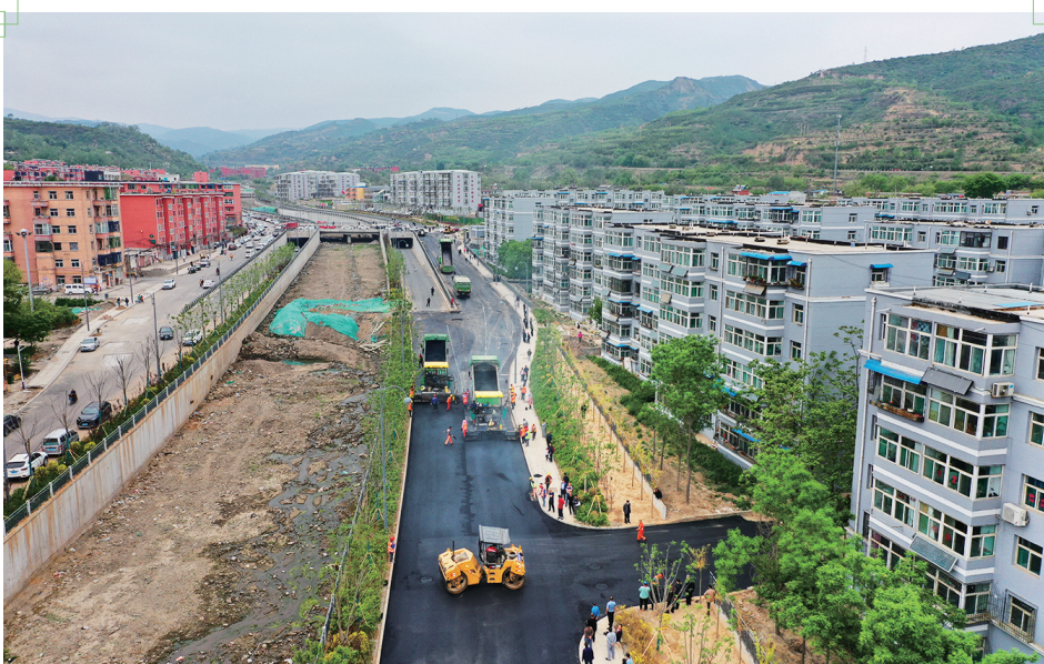
5月14日,在虎峪河道路改造及综合治理工程北岸,中铁大桥局的施工人員正有序进行面层沥青的摊铺施工。全媒体记者 米国伟 摄
