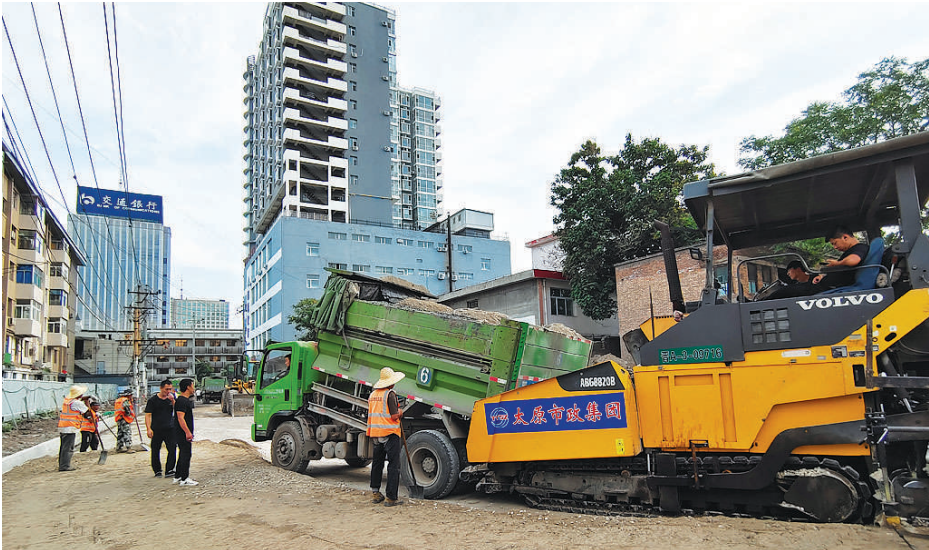
8月4日,杏花岭区奶生堂东巷改造进入冲刺阶段,工人正在进行路面平整作业。此次改造主要对路面、空中电缆以及排水管线进行提档升级,改善周边居民生活环境和出行条件。 张昊宇 摄
