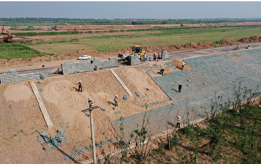
图为汾河清徐段堤内护坡施工。
