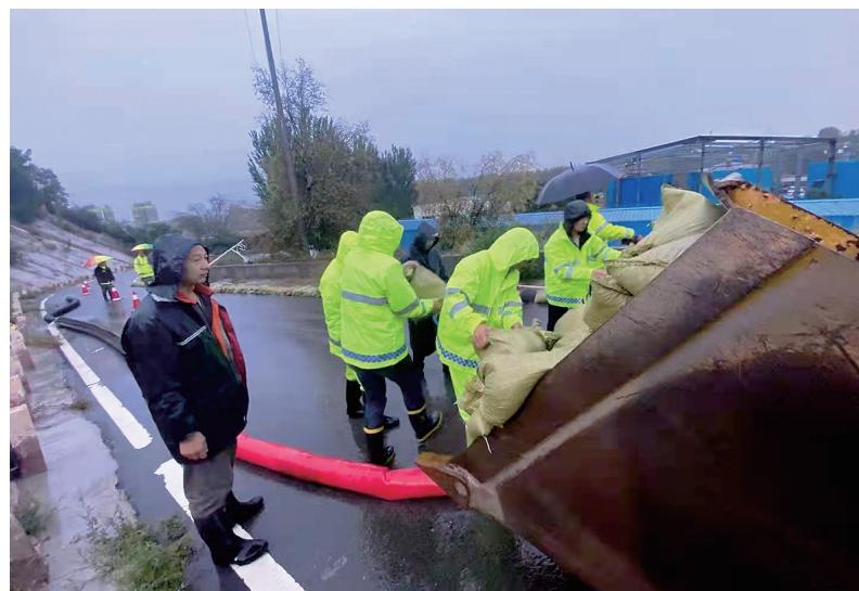
防汛抢险人员抢先堵在上游排水口处,在塌方处南侧90度方向,以拼接方式铺设了长约30米的临时排水管道。同时,调派1台铲车运送大批沙土阻截上游雨水,另外1台铲车运送沙袋,在污水处理站周边搭建起一道防水坝。此外,2台水泵将上游的雨水引流出排,并调派1台吸污车将东山上冲下来的泥水全部吸走。
