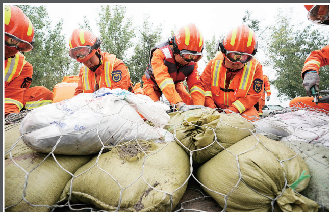
10月11日,抢险人员在汾河下游稷山下迪河坝段加固堤坝。
