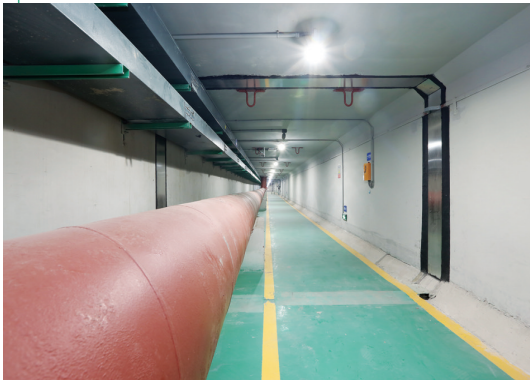
地下综合管廊的污水舱。
