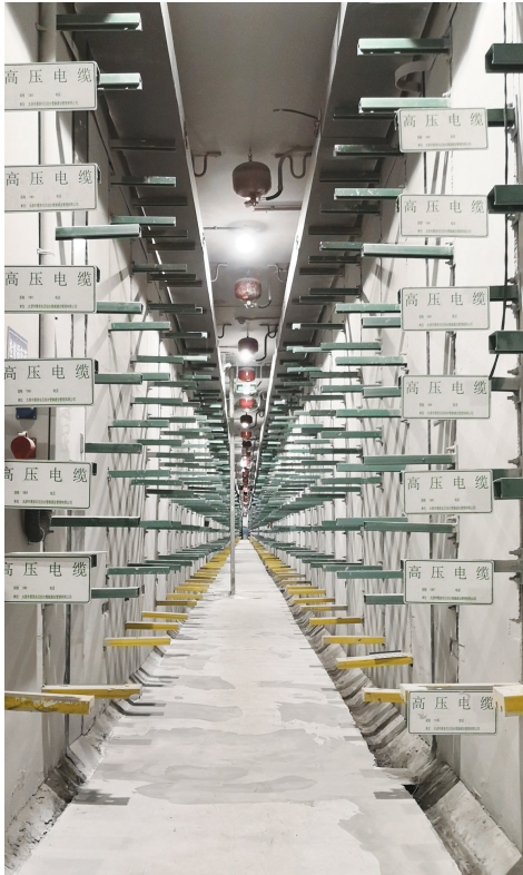
地下综合管廊的电力舱。
