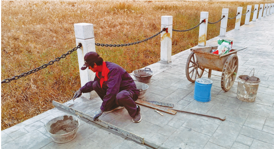
11月3日,汾河景区新建成的步道上,工人正在切割道路伸缩缝,防止入冬后,路面因热胀冷缩而产生裂缝。徐浩轩 摄
