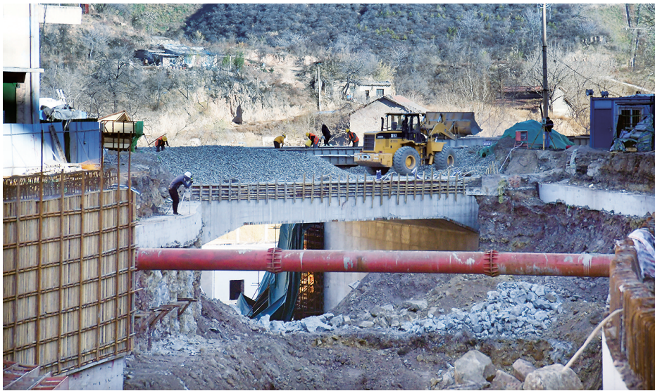
11月14日，九院沙河道路快速化改造官地矿隧道节点绕行工程正在紧张施工。该项目全长740米，采用顶进框架桥下穿官地矿铁路专用线，目前工程量已经过半。建成后，将极大改善周边企业职工和居民的出行条件。
