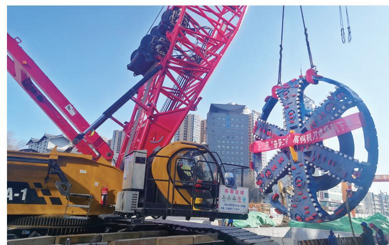
4月2日,在由中铁十四局集团承建的太原地铁1号线103标段,“奋晋二号”盾构机顺利完成吊装下井组装,标志着迎泽桥西站至元站右线区间施工步入盾构作业新阶段。这台盾构机从天津运抵我市,是迎泽大街沿线的第二台下井盾构机。
