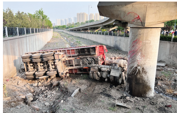
5月6日下午5时30分许,玉门河快速路与104省道交叉口,一辆大货车在行驶过程中突然失控,撞断玉门河桥护栏,冲进河道,司机受伤被困,后被救出送往医院。据了解,由于此处岔口较多,车流量较大,之前也发生过较严重的交通事故。提示广大驾驶员途经此处时务必减速慢行,仔细观察各方向车辆,安全有序通过。申波 摄(报料人:胡先生 报料费:30元)
