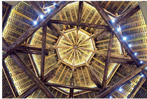
► 河南浚县古城内的土圆粮仓的木梁架结构仓顶。
