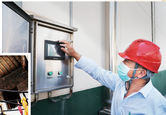
► 工作人员在中央储备粮鹤壁直属库有限公司浚县分公司内调试内环流均温控制系统。
