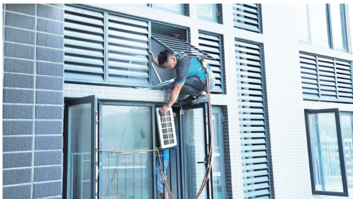
图为安装师傅顶着烈日高空作业为客户安装空调。
