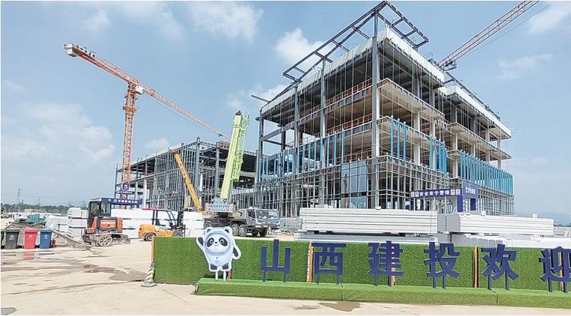
太忻双碳产业科技园主体正在建设中,园区从设计、建造紧密围绕低碳的概念,采用了钢结构装配式建筑。
