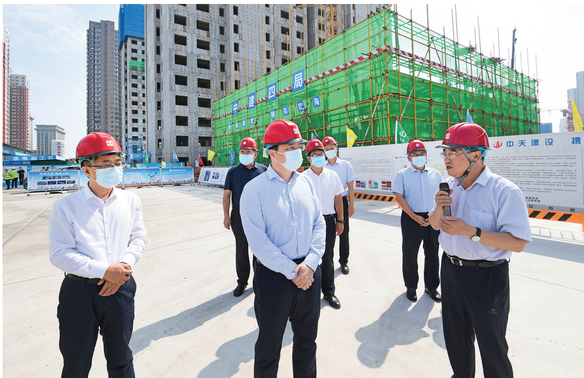
省委常委、市委书记韦韬在中海天钻项目建设工地督导检查扬尘污染防治工作。 梁琛 摄
