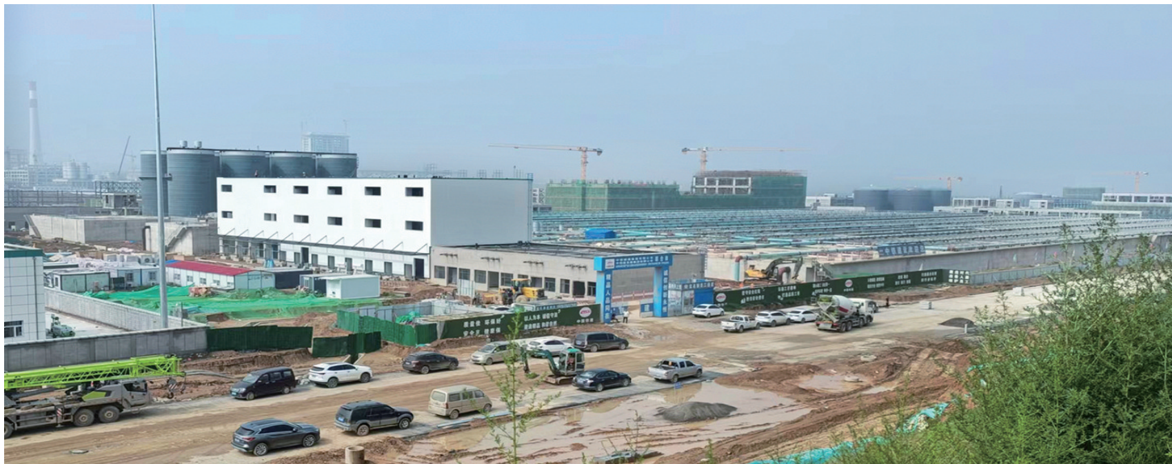
山西合成生物产业生态园区一期在建项目。
