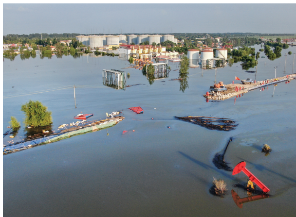
8月5日，抢险人员在溃口处进行封堵作业（无人机照片）。
