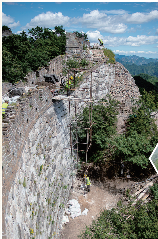
在“西大墙”段一处工地,工人通过机械滑轮将墙下的施工材料运至长城上。
