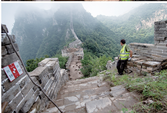
上图是工人在研究性修缮段的一处工地开始进行考古发掘;下图是工人在进行部分发掘工作后,清理地面并收集了一些相对完整的老砖用于后续修缮。
