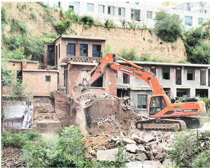
图为自建房拆除中。
