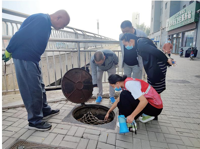
从9月5日开始,光华街社区干部、网格员带领维修人员对辖区下水井防坠网进行排查和安装。当天上午,大家以光华街18号院为中心,向东和向西分别对各个下水井进行防坠网检修安装,并对管道中垃圾、淤泥及时进行清掏。
