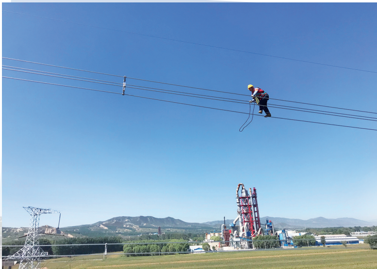
图为国网山西超高压输电公司运检三分部五班副班长武军高空走线验收。
