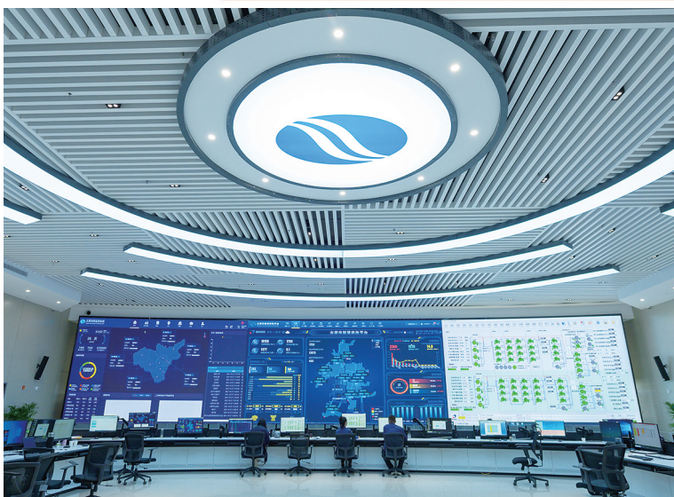
太原市集中供热调度中心工作人员正在监测相关数据。该中心是全市供热系统的“智慧大脑”“神经中枢”,负责对全系统的源、网、站、户(即热源厂、管网、热力站、用户)及运行参数进行实时监测、科学调整。
