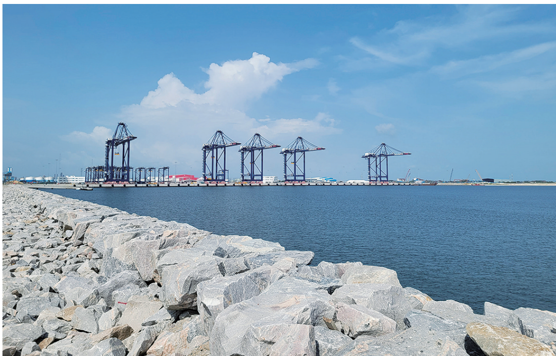
10月31日在尼日利亚拉各斯拍摄的中企承建的莱基深水港。
