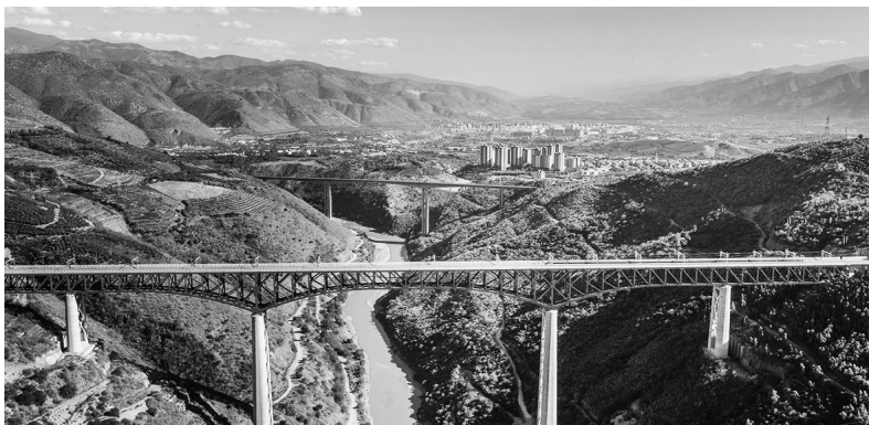
“复兴号”列车通过中老铁路元江特大桥(2022年11月23日摄,无人机照片)。
