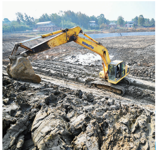
工人在湖南省湘潭市湘乡市泉塘镇双江村使用机械修建用于农田灌溉的蓄水塘(11月17日摄)。
