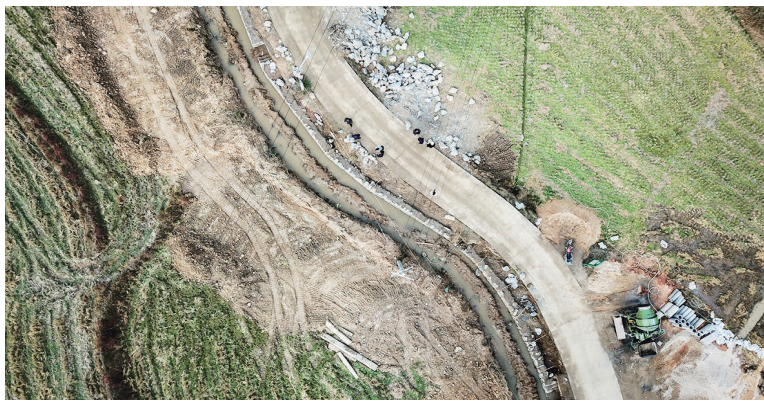
工人在湖南省湘潭市湘乡市梅桥镇梅桥村进行水渠改造作业。(11月17日摄)
