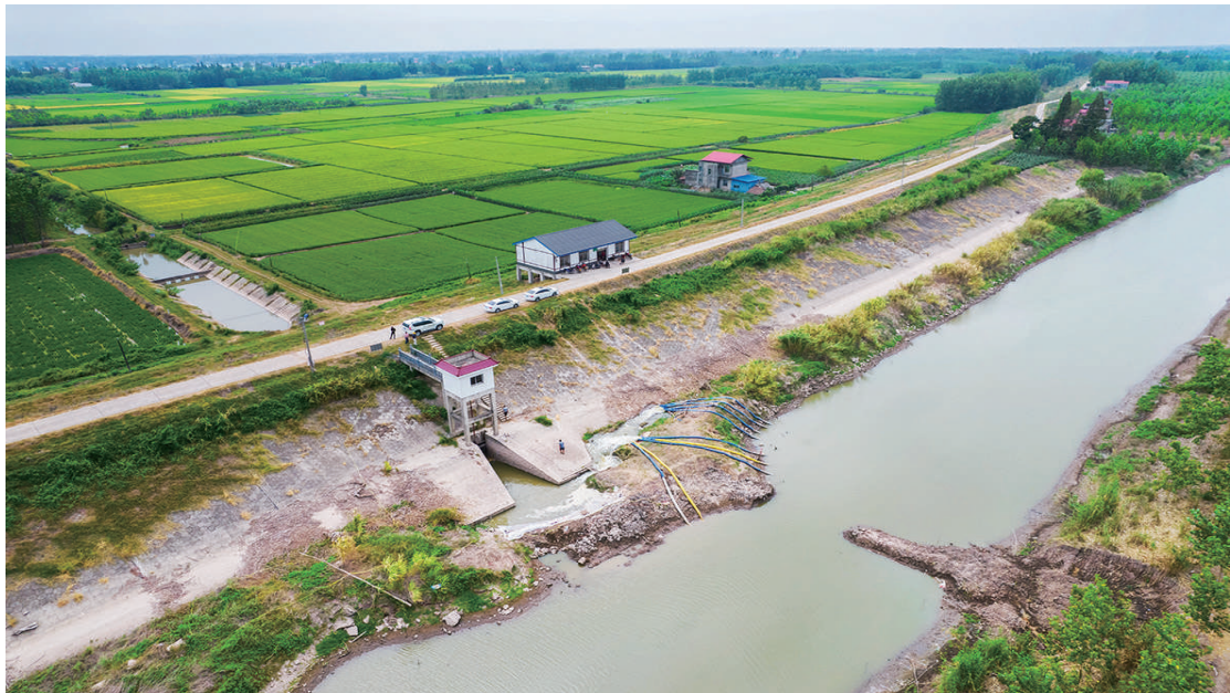
这是8月25日在湖南省常德市安乡县三岔河镇拍摄的一处提水作业点(无人机照片)。
