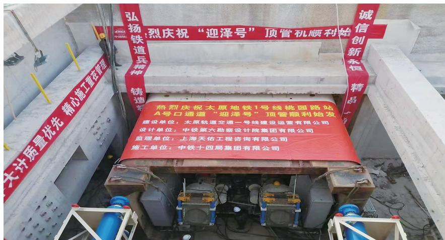
本报讯(记者 李涛 通讯员 肖兰伟)14米深的地下,在千斤顶的推动下,一节节矩形通道正在从迎泽大街北往南依次顶进,而路面的交通没有受到丝毫影响。12月21日,在中国铁建投资集团联合投资建设、中铁十四局承建的地铁1号线103标段桃园路站,下穿迎泽大街的人行过街通道施工正式启动。此次,采用的是顶管工艺,33节矩形通道犹如积木,将在地下完成组装。今后,市民从迎泽大街的北侧,沿着该通道可直达桃园路地铁站。
