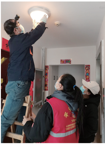
网格员更换了龙城南小区的故障楼道灯。
